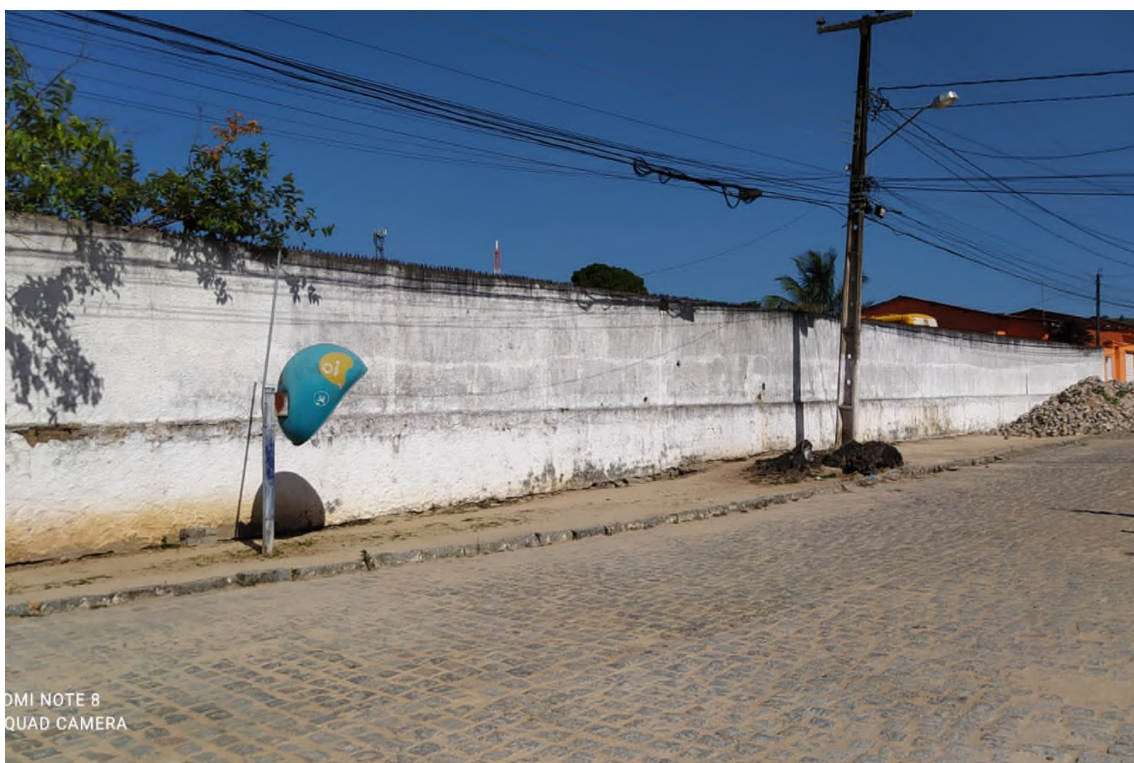
Foto 02 - Vista frontal do terreno, a partir da Av. Getúlio Vargas
