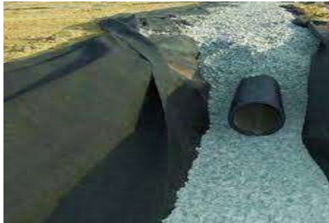
Execução de drenagem com tubo PEAD.
