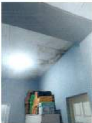
Foto 04- Infiltrações aparentes.
