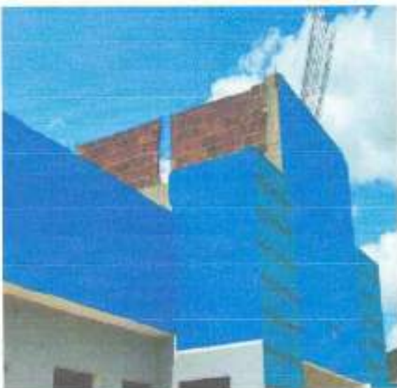
Estrutura de vedação do reservatório inacabada
