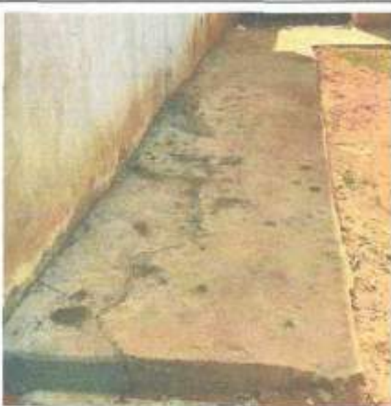
Piso do passeio mal executado e/ou trincado
