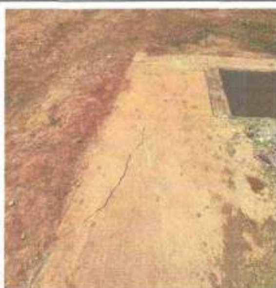
Piso do passeio mal executado e/ou trincado
