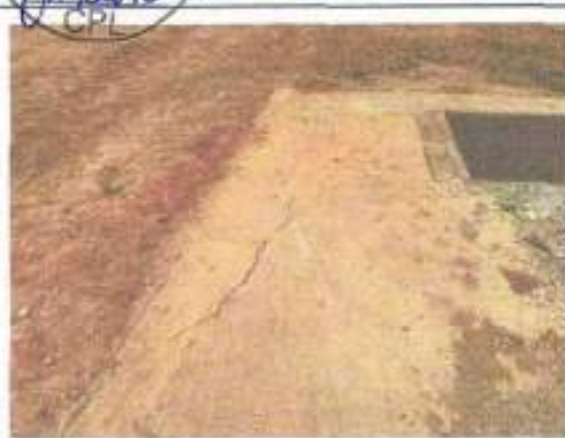
Piso fissurado, rachado e desnivelado
