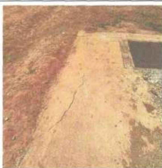
Piso do passeio mal executado e/ou trincado
