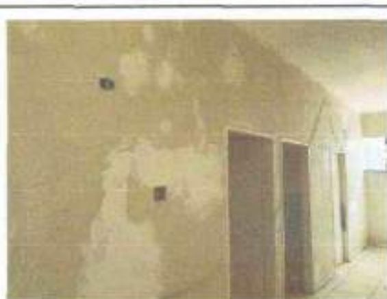
Pintura e emboço manchado e com sinais de infiltração
