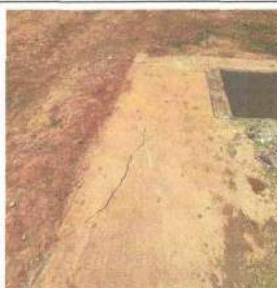
Piso do passeio mal executado e/ou trincado
