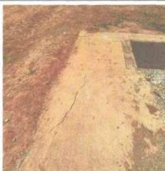
Piso do passeio mal executado e/ou trincado
