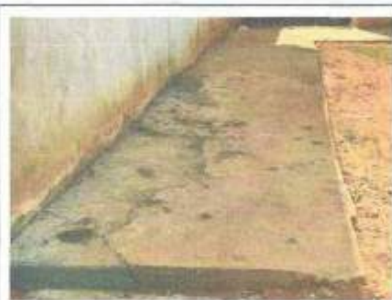
Piso fissurado, rachado e desnivelado
