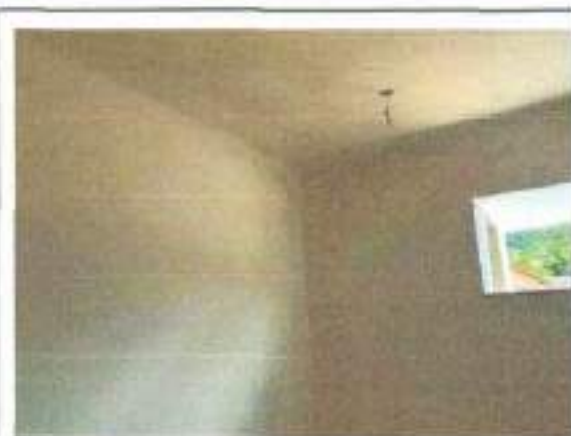
Pintura e emboço manchado e com sinais de infiltração
