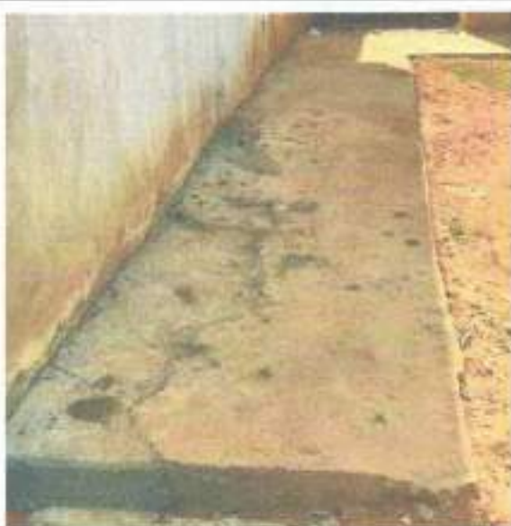
Piso do passeio mal executado e/ou trincado
