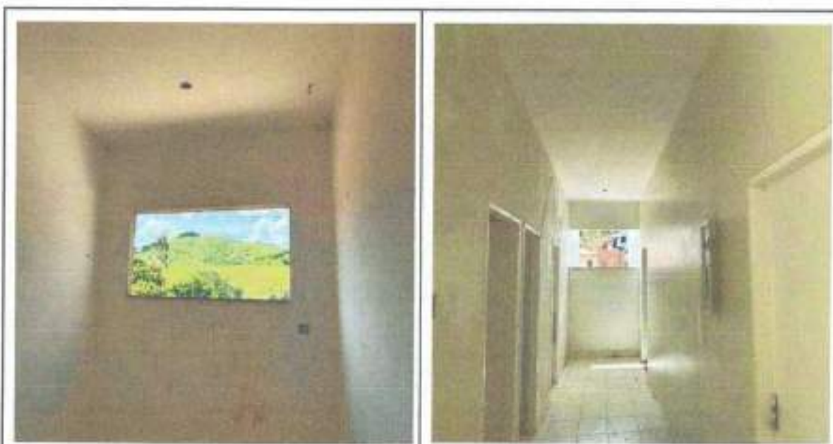
Pintura realizada sem o fechamento do ambiente por esquadrias
