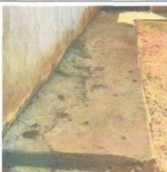
Piso do passeio mal executado e/ou trincado
