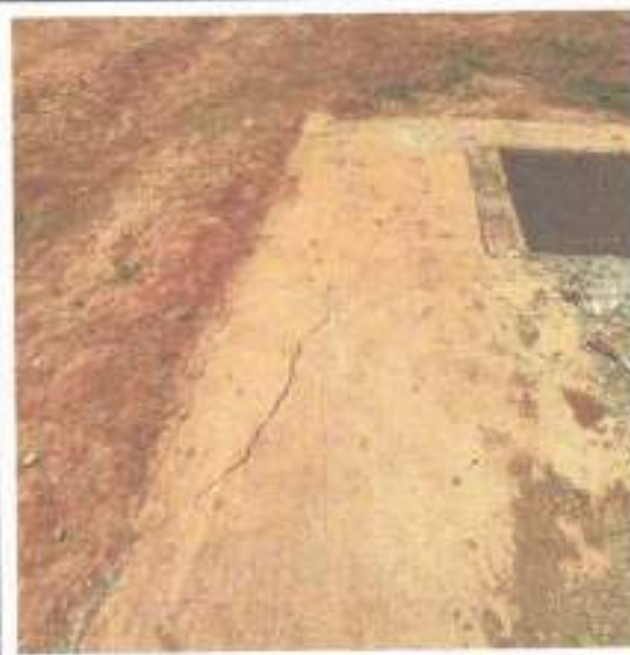
Piso do passeio mal executado e/ou trincado
