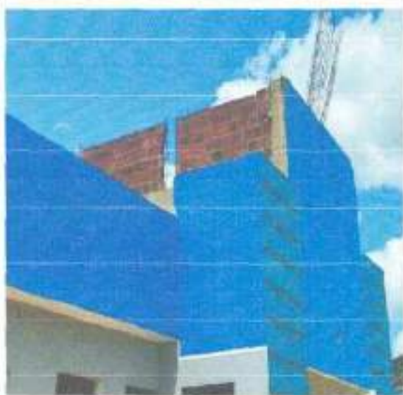
Estrutura de vedação do reservatório inacabada
