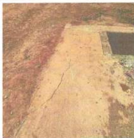
Piso do passeio mal executado e/ou trincado
