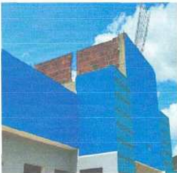
Estrutura de vedação do reservatório inacabada
