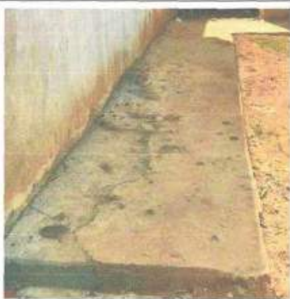
Piso do passeio mal executado e/ou trincado
