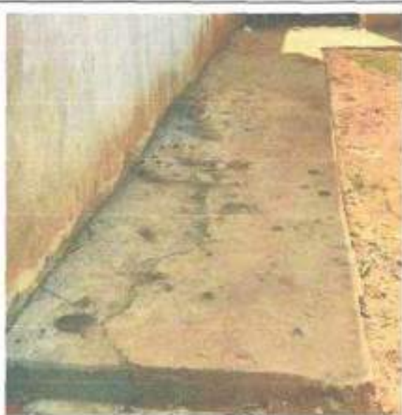
Piso do passeio mal executado e/ou trincado
