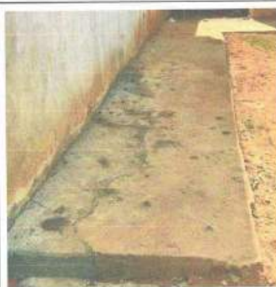
Piso do passeio mal executado e/ou trincado
