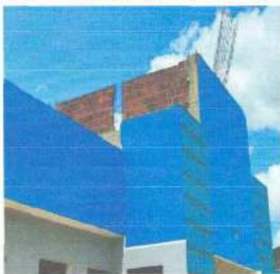
Estrutura de vedação do reservatório inacabada
