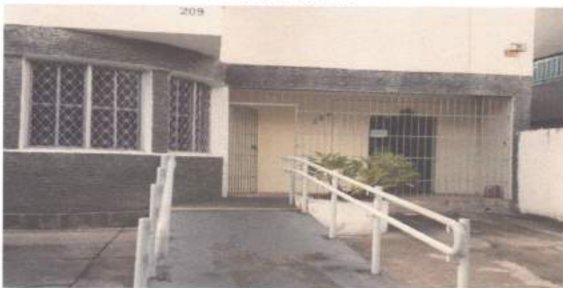
PARTE EXTERNA – ENTRADA DA EMPRESA
