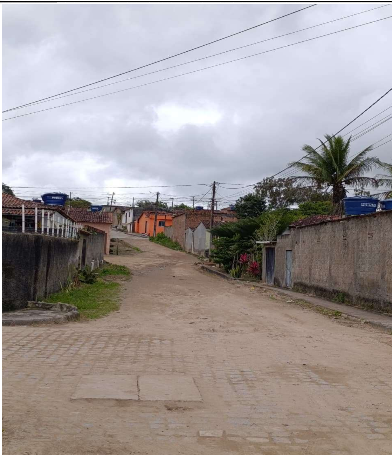
CONSTRUÇÃO DE CALÇAMENTO FOTO - 3
