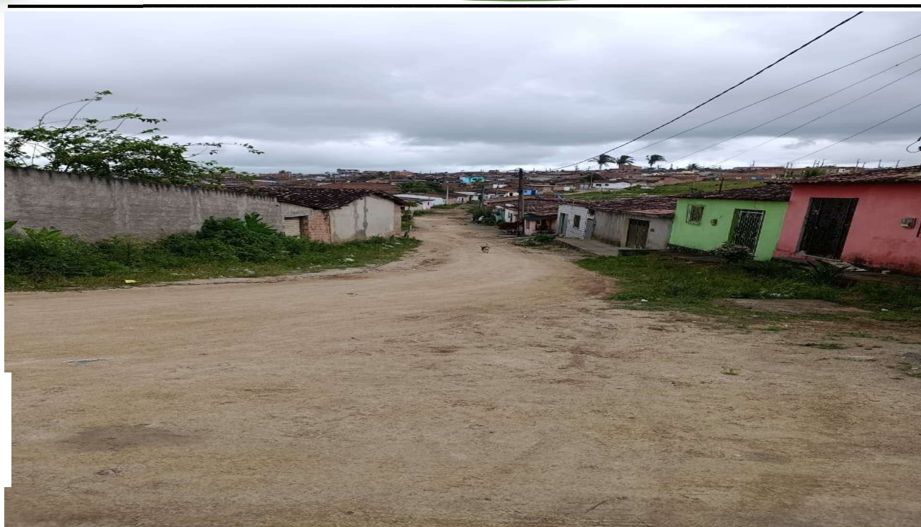
CONSTRUÇÃO DE CALÇAMENTO FOTO - 1
