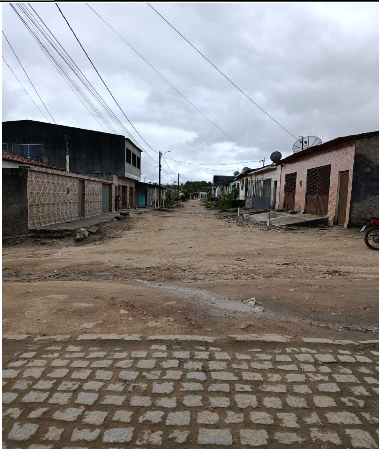
CONSTRUÇÃO DE CALÇAMENTO FOTO - 2
