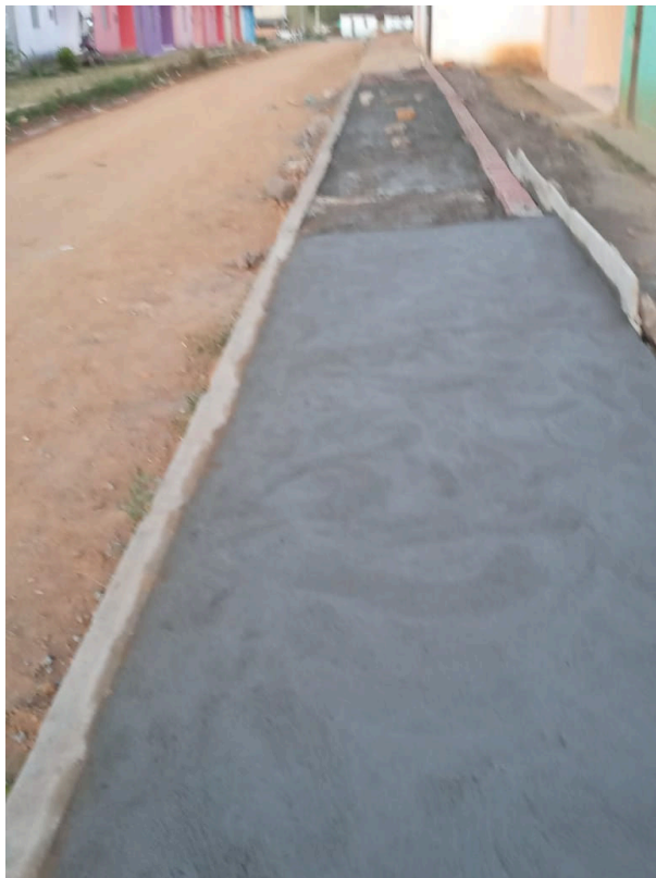
FIGURA 1: CALÇADA DA RUA
