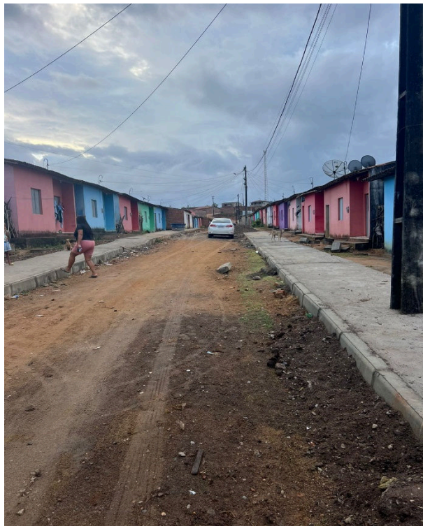
FIGURA 3: CALÇADA DA RUA
