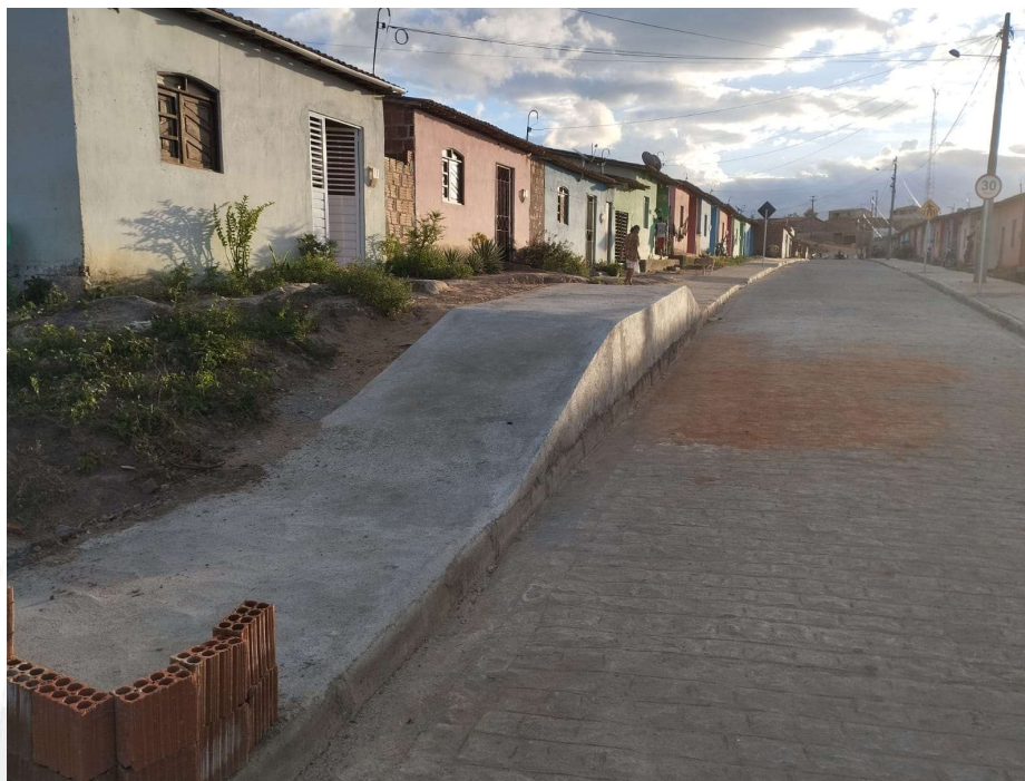
FOTO 03 – APLICATION DO MEIO-FIO E ATERRO DAS CALÇADAS
