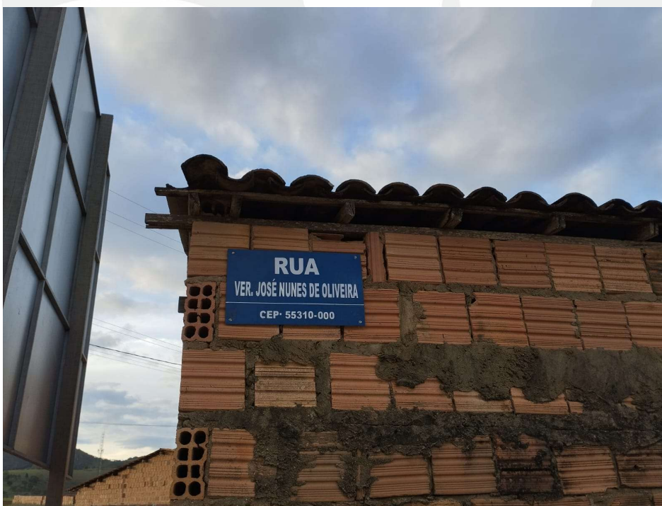
FOTO 02 – APLICAÇÃO DAS PLACAS DE IDENTIFICAÇÃO DE RUA
