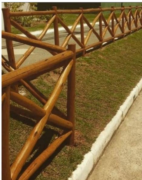
O guarda corpo de proteção de peças de eucalipto tratada é uma estrutura de segurança que tem como objetivo proteger as pessoas em locais elevados, como escadas, sacadas, varandas e terraços. Aqui estão os passos para executar o serviço de um guarda corpo de proteção de peças de eucalipto tratada:
