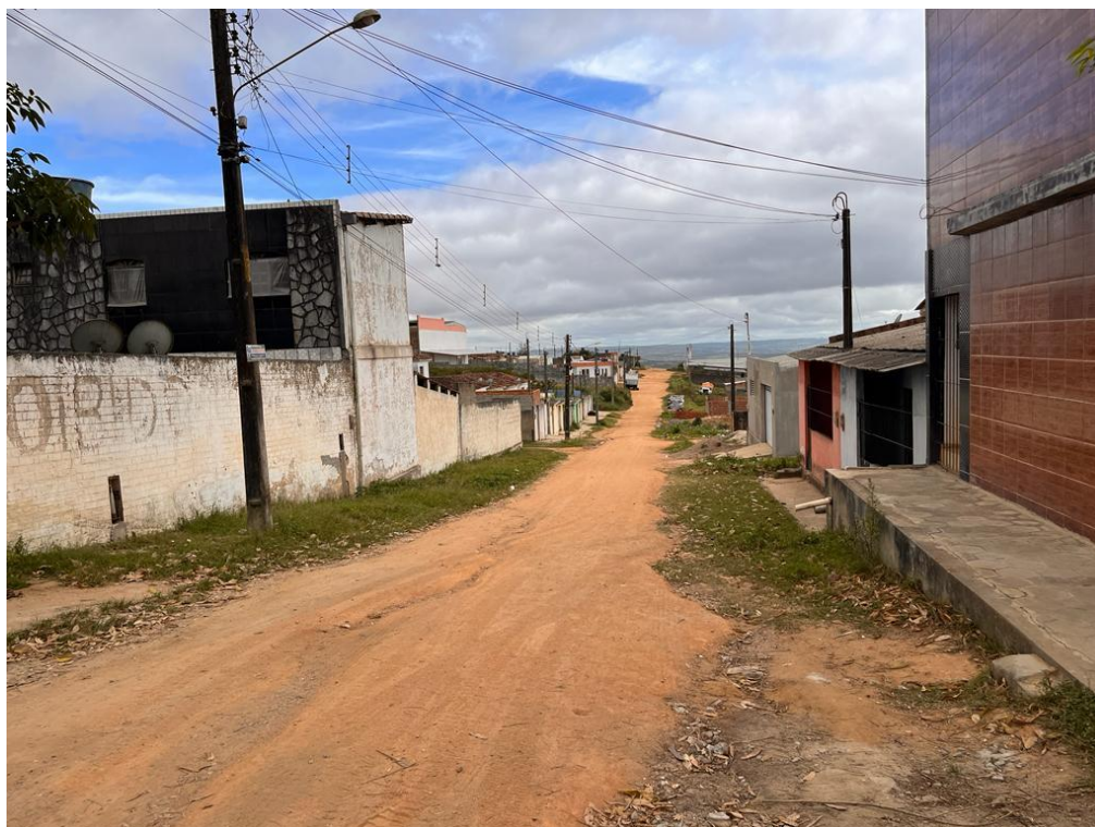
Rua Andre Alves de Noronha-2
