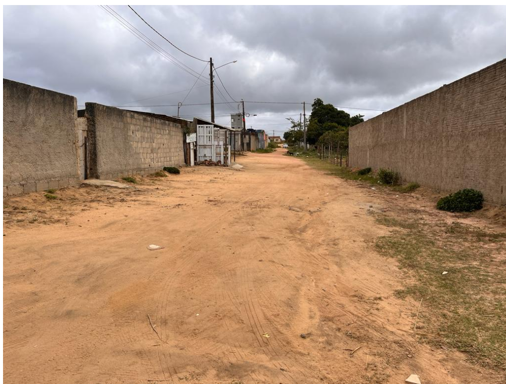
Trav Antonio Vaz da Costa - trecho 5
