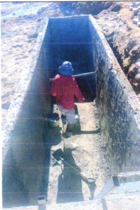
CONTINUAÇÃO - DRENAGEM PERO VAZ DE CAMINHA
