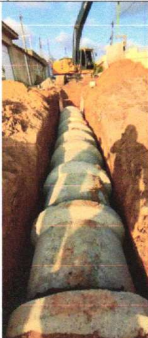
CONTINUAÇÃO DA DRENAGEM – COAB II
