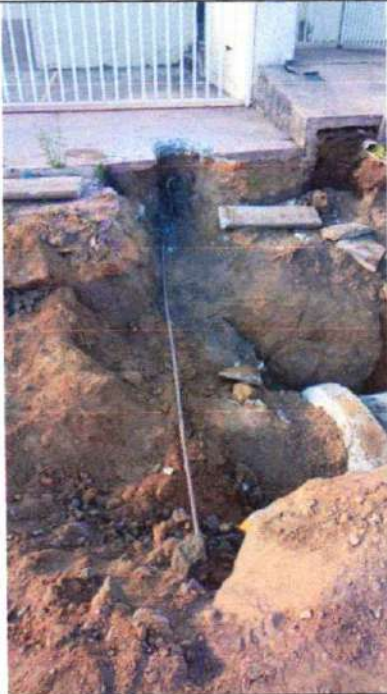
CONTINUAÇÃO – PAV PERO VAZ DE CAMINHA
