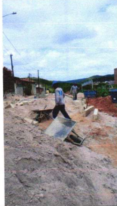
PAVIMENTAÇÃO RUA PROJETADA 05
