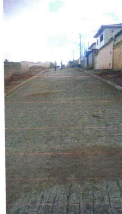
PAVIMENTAÇÃO RUA PROJETADA 03
