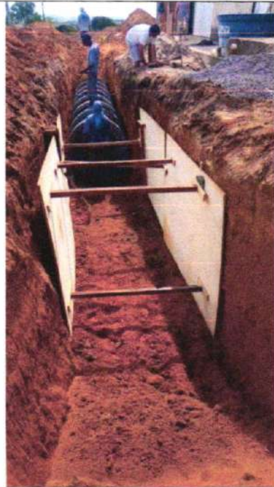
CONTINUAÇÃO DA DRENAGEM – COAB II
