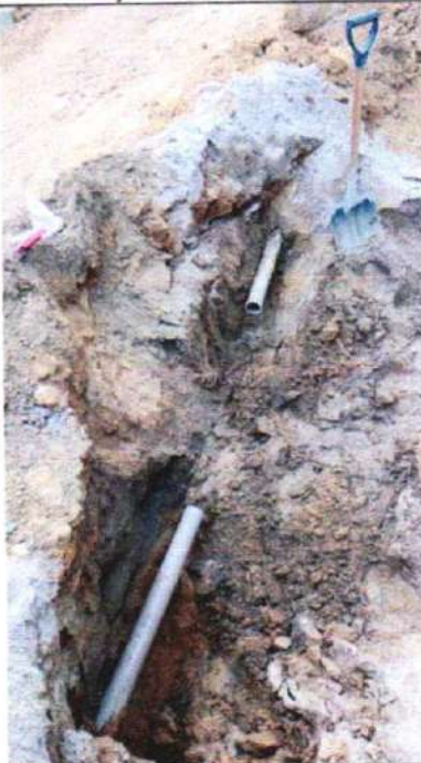
PAVIMENTAÇÃO RUA PROJETADA 03
