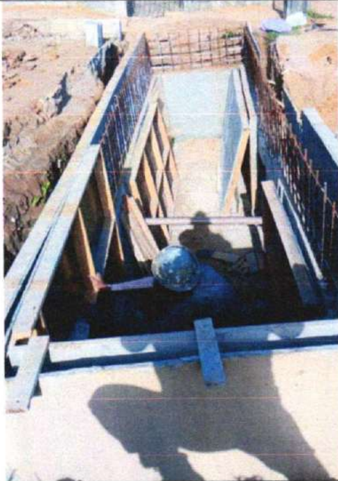
CONTINUAÇÃO - DRENAGEM PERO VAZ DE CAMINHA
