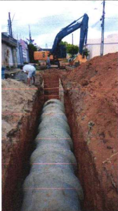
CONTINUAÇÃO DA DRENAGEM – COAB II
