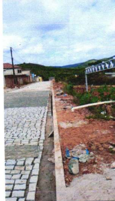
PAVIMENTAÇÃO RUA PROJETADA 05
