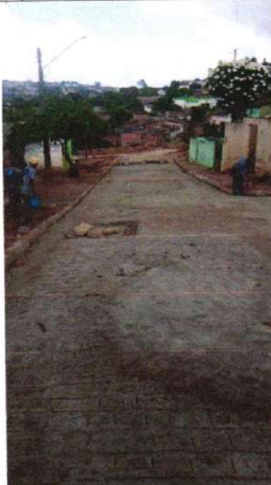
CONTINUAÇÃO – PAV PERO VAZ DE CAMINHA
