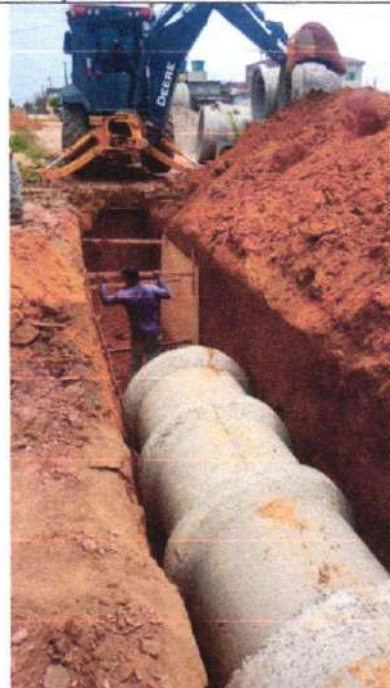
CONTINUAÇÃO DA DRENAGEM – COAB II
