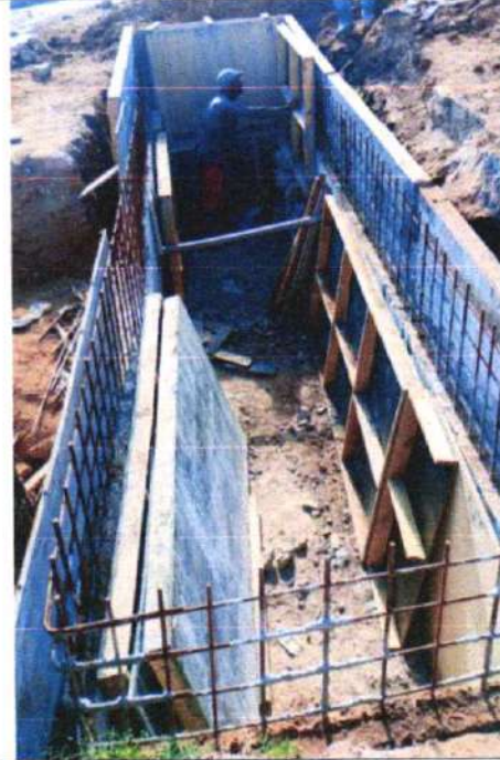
CONTINUAÇÃO - DRENAGEM PERO VAZ DE CAMINHA
