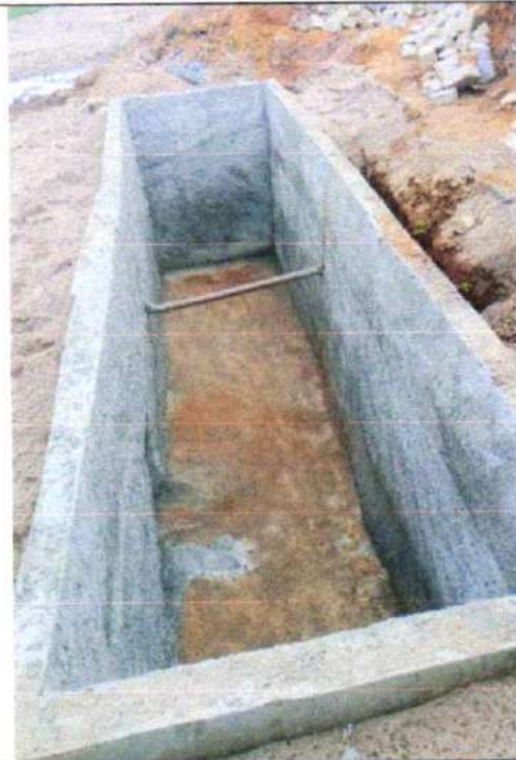
CONTINUAÇÃO - DRENAGEM PERO VAZ DE CAMINHA
