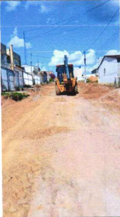
PAVIMENTAÇÃO RUA PROJETADA 03
