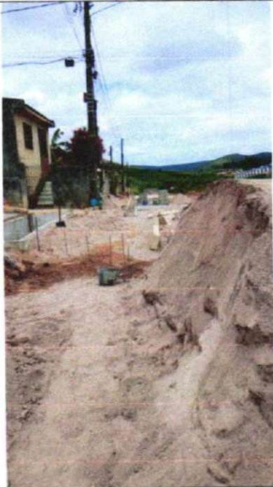
PAVIMENTAÇÃO RUA PROJETADA 05
