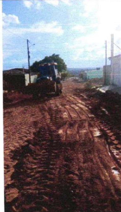
PAVIMENTAÇÃO RUA PROJETADA 03
