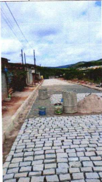
PAVIMENTAÇÃO RUA PROJETADA 05
