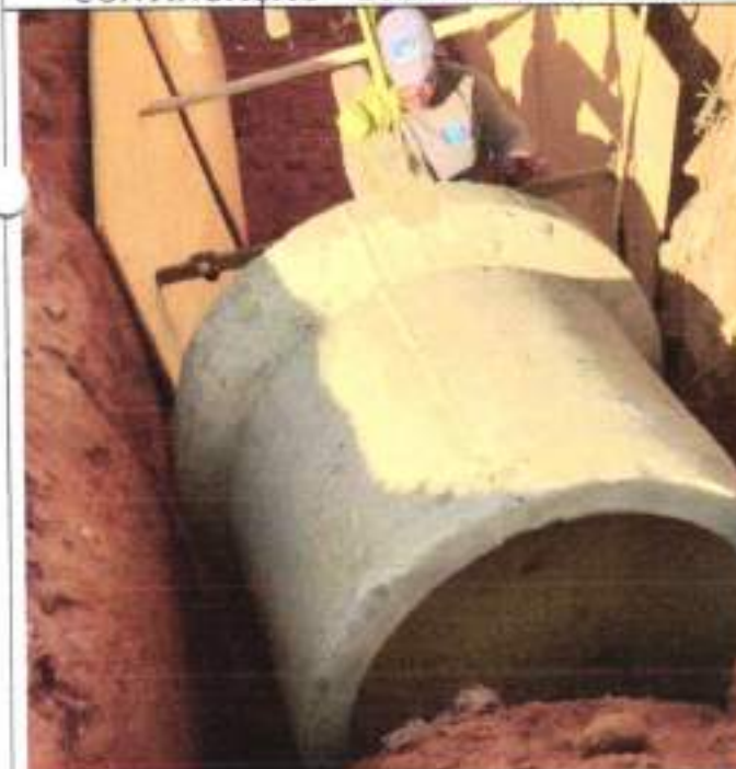
CONTINUAÇÃO – DRENAGEM JATOBA
