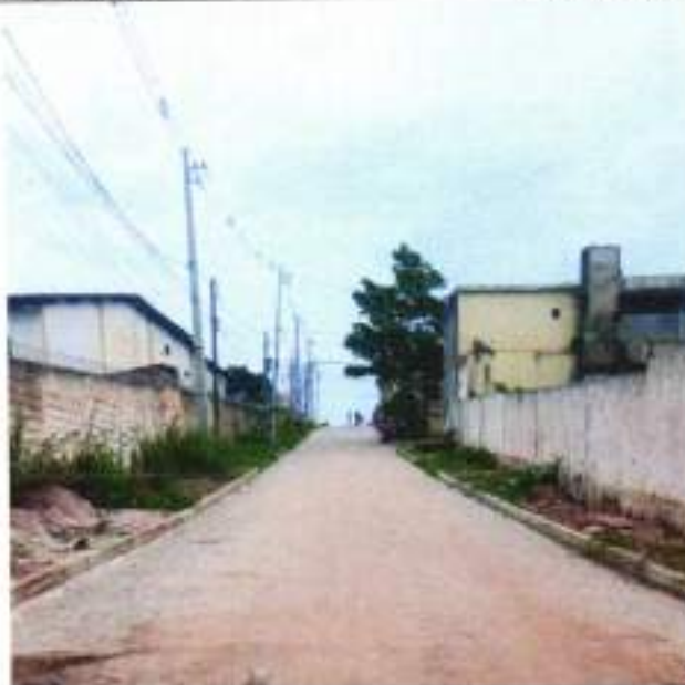
Conclusão Rua Projetada 06
