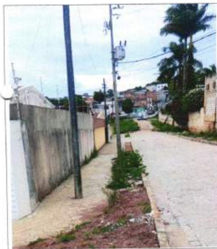
Conclusão Rua Projetada 09
