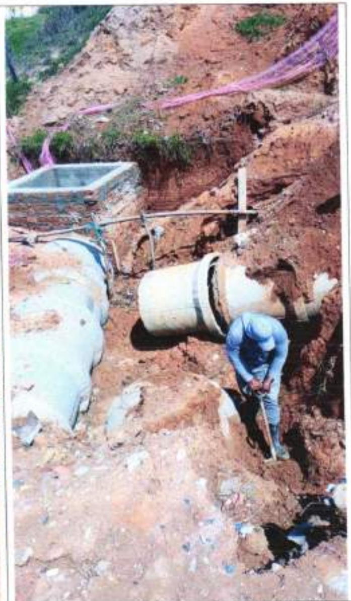
CONTINUAÇÃO – DRENAGEM JATOBA
