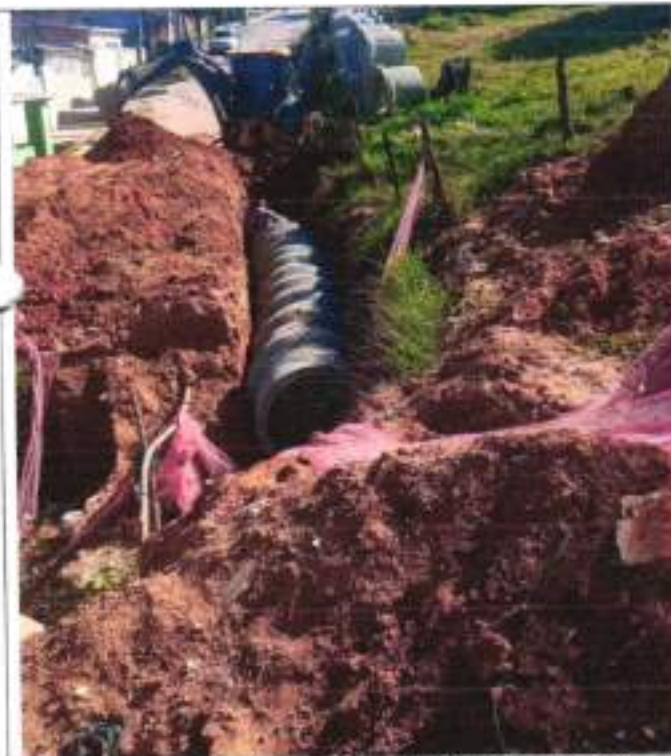
CONTINUAÇÃO - DRENAGEM JATOBA
