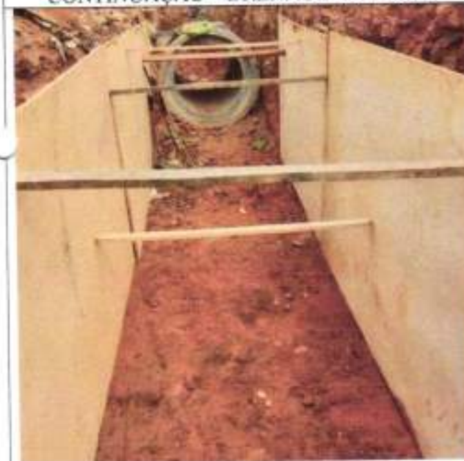
CONTINUAÇÃO - DRENAGEM JATOBA
