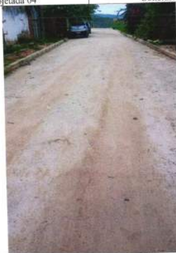
Conclusão Rua Projetada 04
