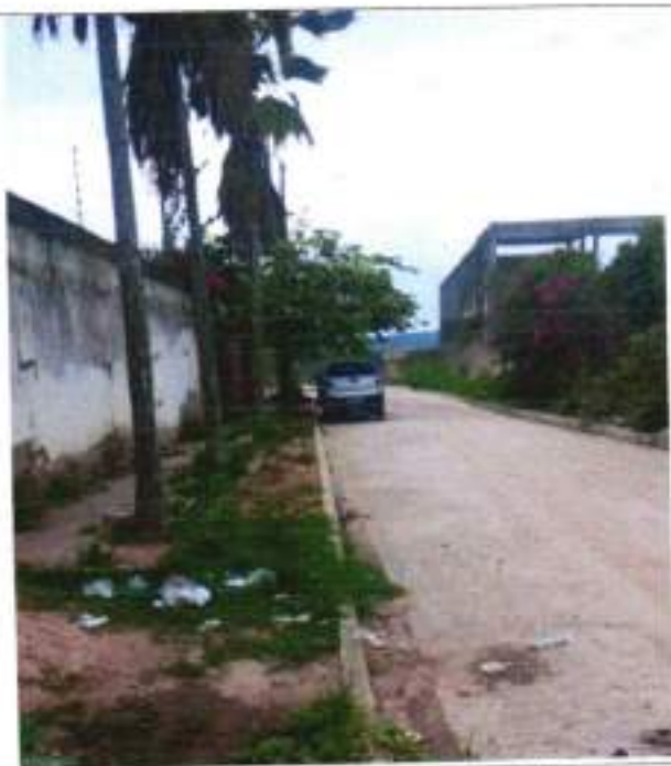
Conclusão Rua Projetada 04
