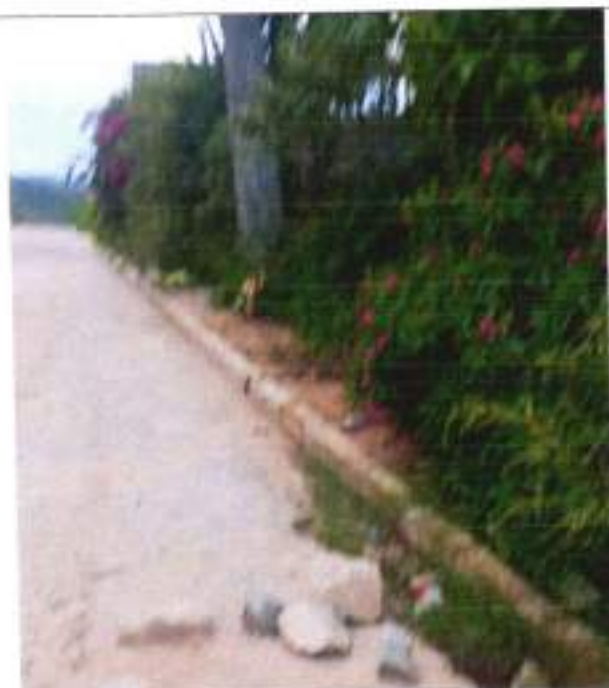
Conclusão Rua Projetada 04
