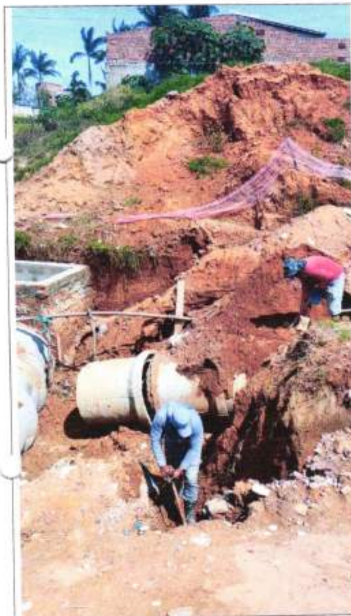
CONTINUAÇÃO – DRENAGEM JATOBÁ
