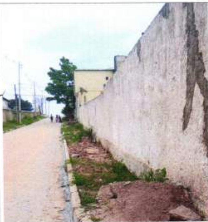
Conclusão Rua Projetada 06
