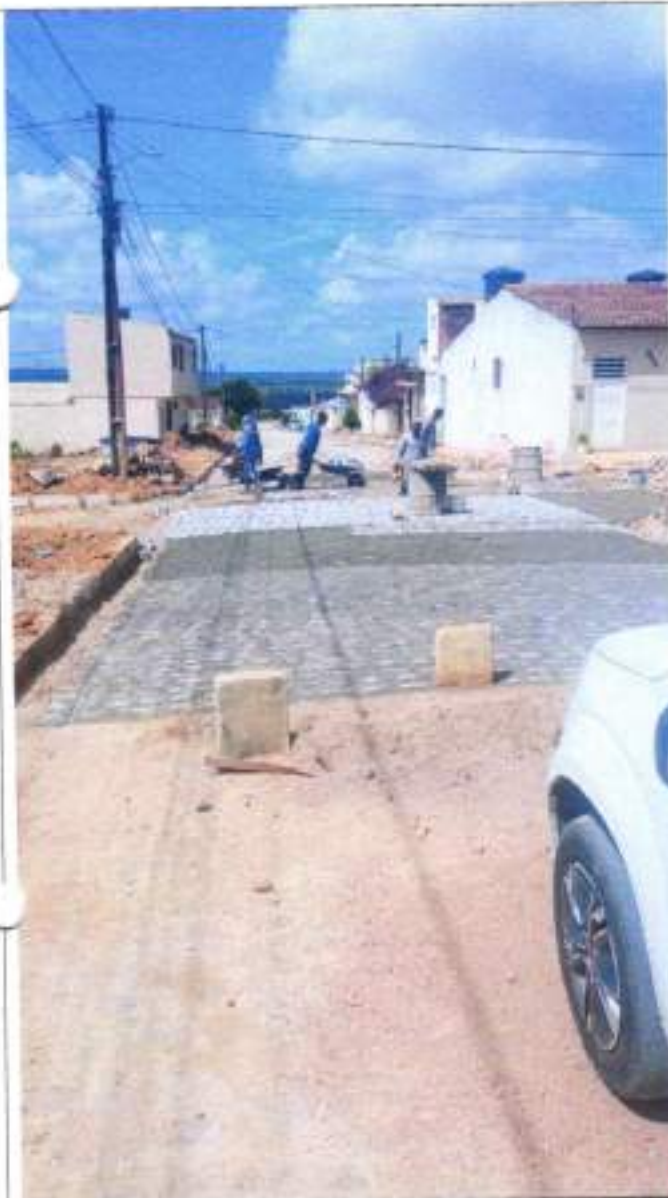
RUA JOVELINA - CONCLUSÃO
