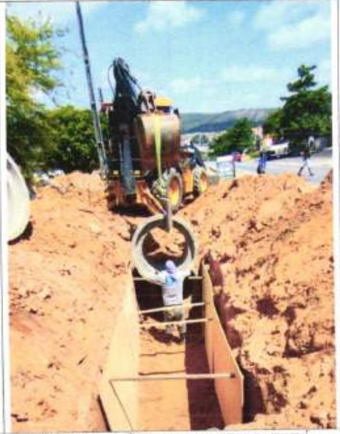
CONTINUAÇÃO - DRENAGEM JATOBA
