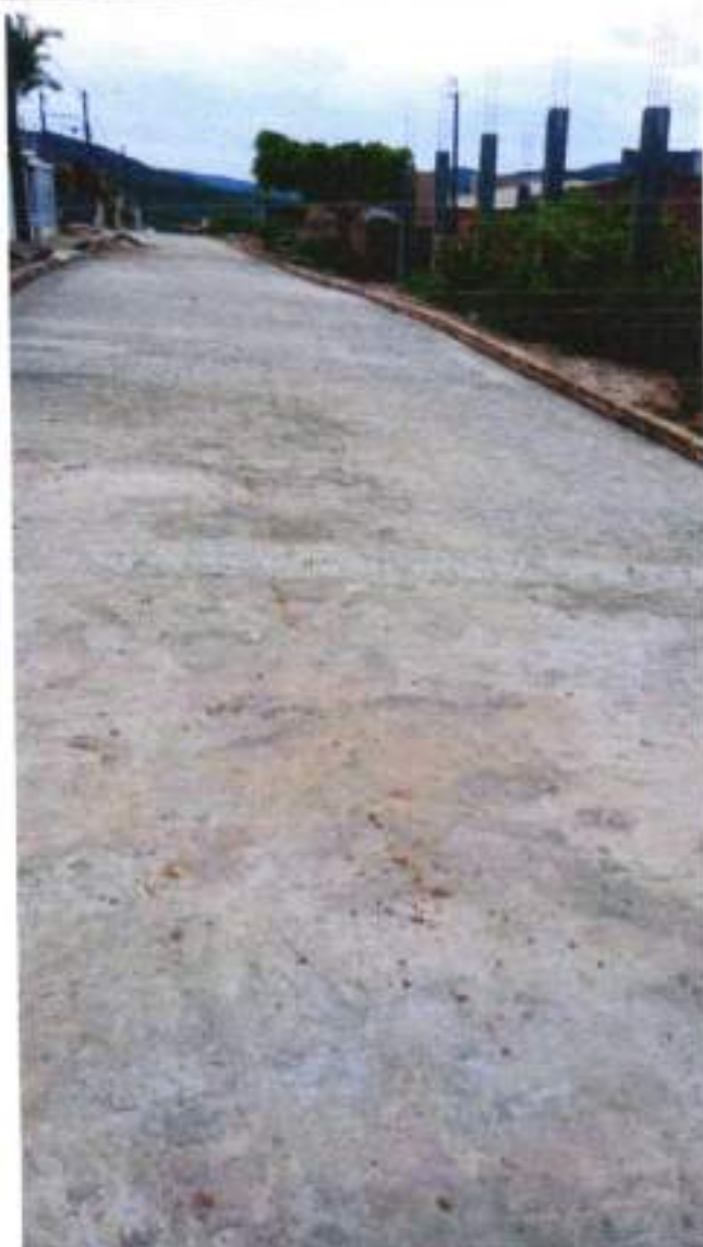
Conclusão Rua Projetada 03
