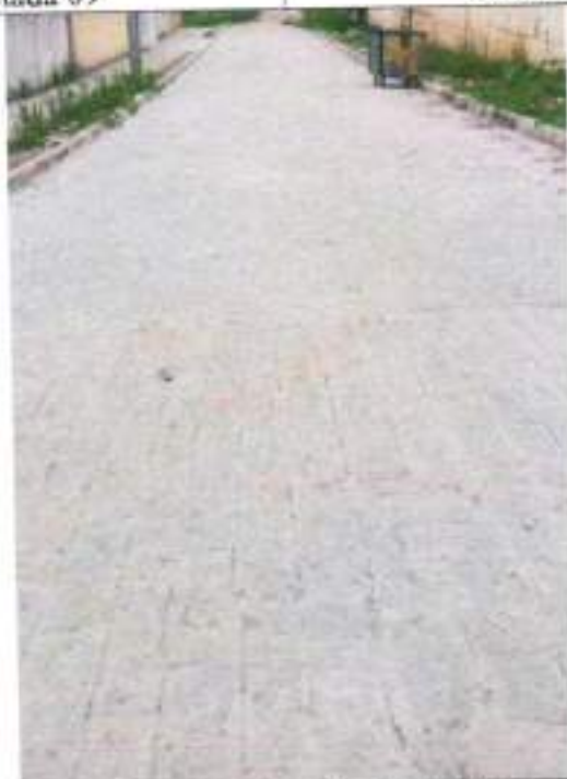
Conclusão Rua Projetada 09
