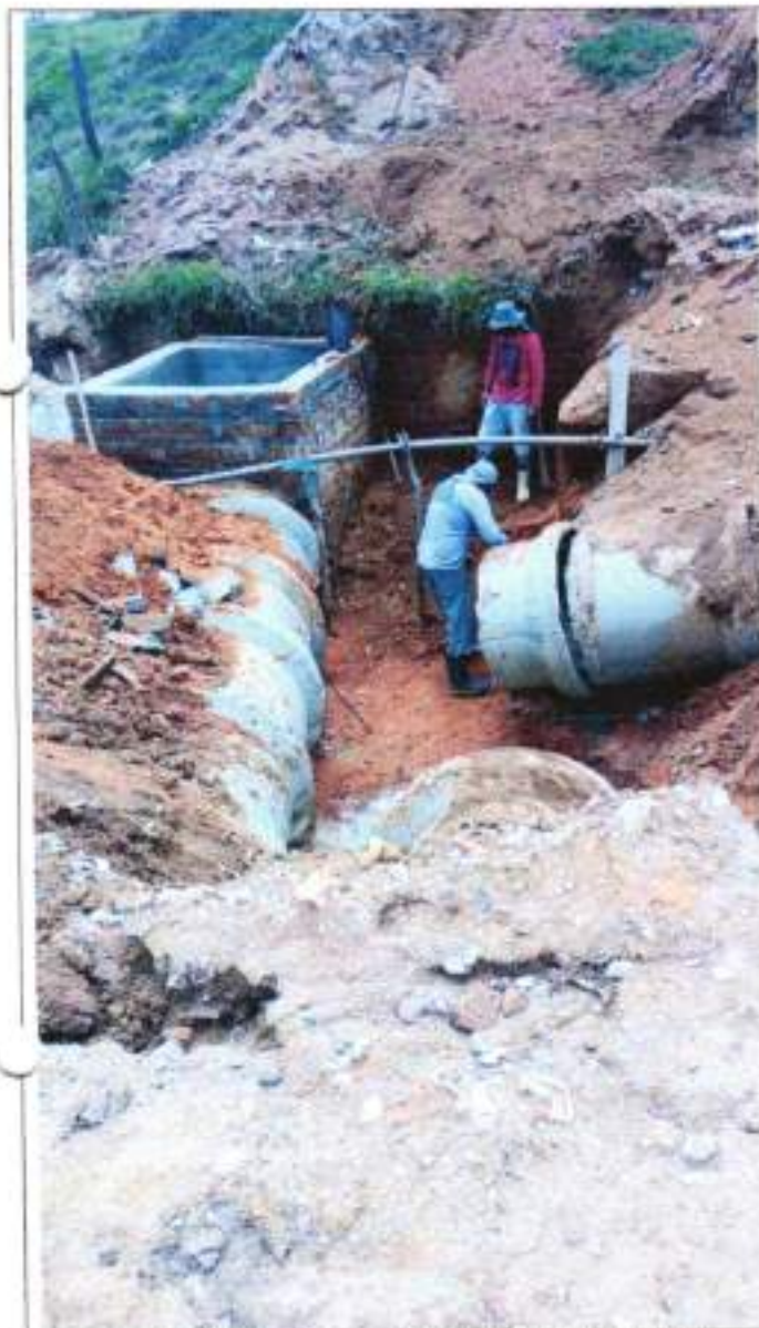
CONTINUAÇÃO - DRENAGEM JATOBA
