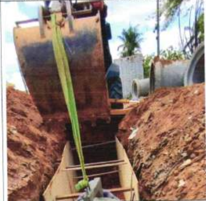
CONTINUAÇÃO - DRENAGEM JATOBA
