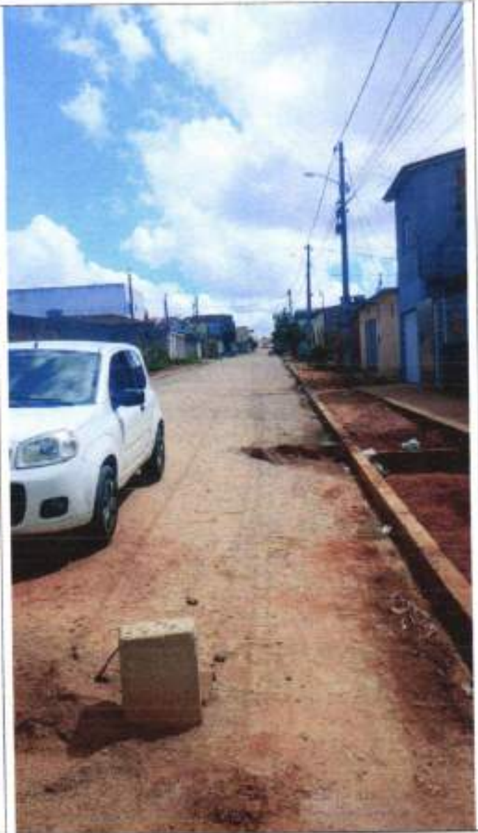
RUA JOVELINA - CONCLUSÃO
