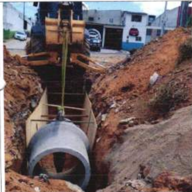
CONTINUAÇÃO - DRENAGEM JATOBA
