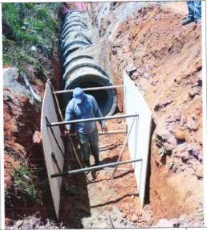
CONTINUAÇÃO - DRENAGEM JATOBA
