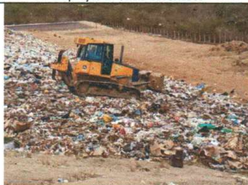
Foto 6 – Espalhamento e compactação dos resíduos na frente de operação.
