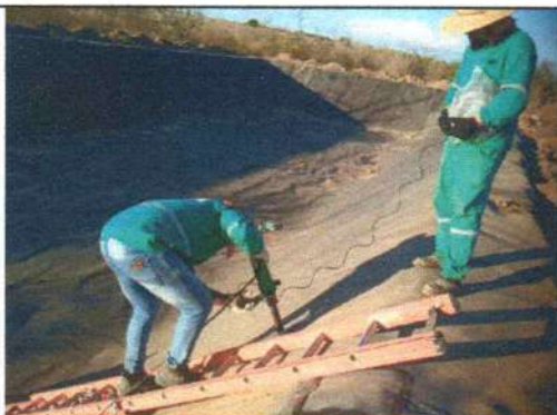
Foto 3 – Utilização de manta de PEAD, para impermeabilização de nova lagoa de acumulação de chorume
