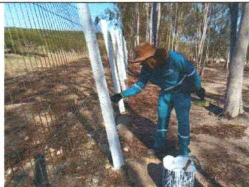
Foto 2 – Pintura das estacas no perímetro do aterro sanitário
