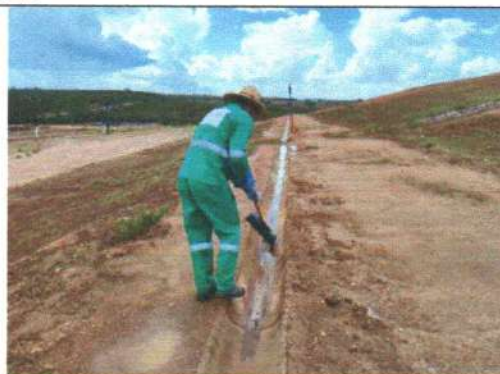
Foto 2 – Limpeza dos dispositivos de drenagem de águas pluviais
