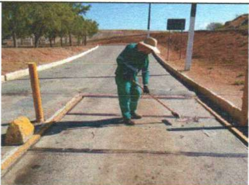
Foto 3 – Limpeza na plataforma da balança rodoviária
