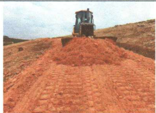
Foto 4 – Manutenção das vias de acesso à frente de operação
