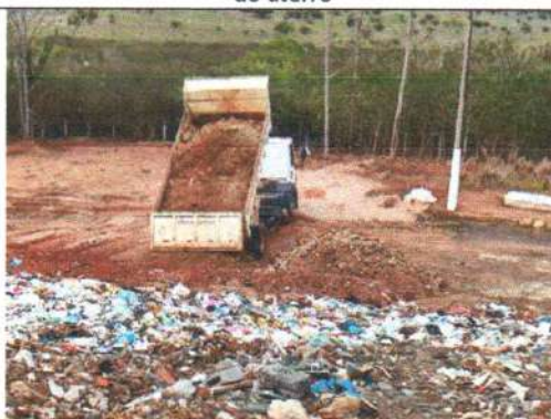
Foto 4 – Transporte e estocagem de solo para cobertura dos resíduos
