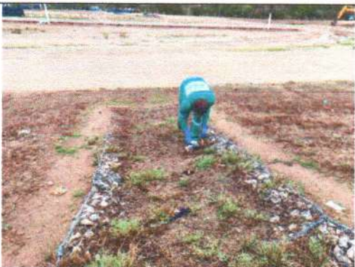
Foto 3 – Limpeza dos dispositivos de drenagem de águas pluviais na célula de resíduos
