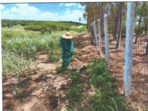
Foto 3 – Capinação realizada no perímetro externo do aterro sanitário
