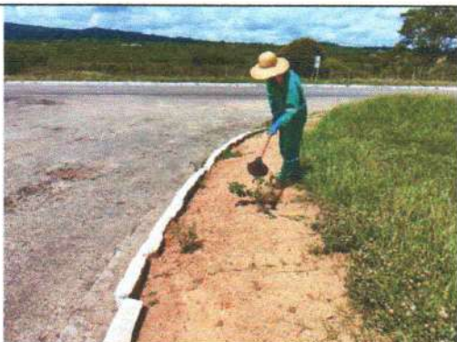
Foto 3 – Capinação realizada na área interna do aterro sanitário
