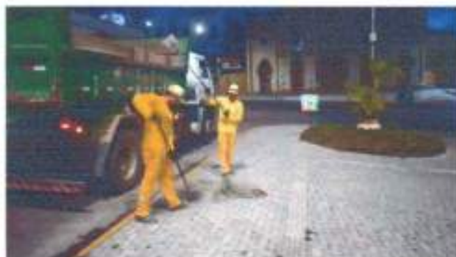
AV. SANTO ANTÔNIO. CENTRO
