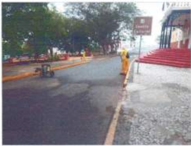
Rua Afonso Pena ( são José )
