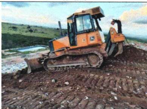
Foto 6 – Cobertura dos resíduos na célula de resíduos
