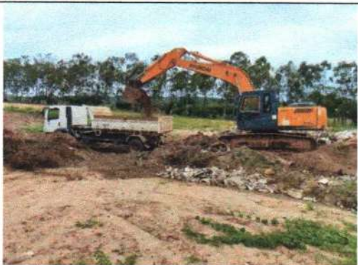
Foto 5 – Carga e transporte de solo para cobertura dos resíduos sólidos
