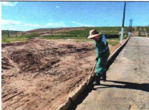
Foto 3 – Capinação nos meio fios do acesso interno do aterro
