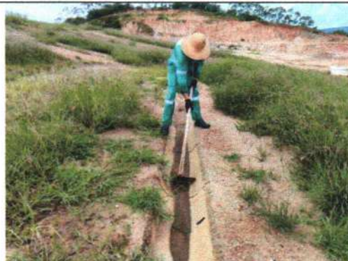
Foto 4 – Limpeza no dispositivo de drenagem
