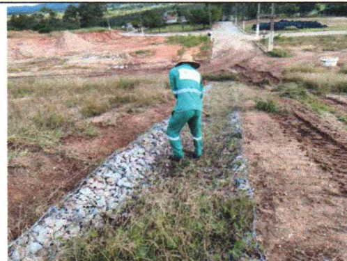
Foto 6 – Limpeza dos dispositivos de drenagem.
