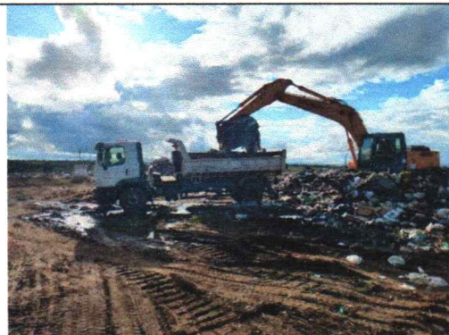
Foto 5 – Carga e transporte de resíduos sólidos para a frente de operação
