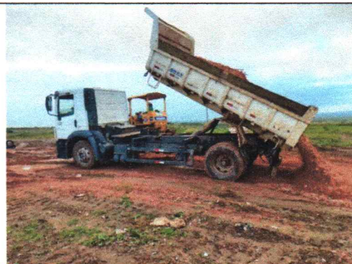
Foto 4 – Transporte e estocagem de solo para cobertura dos resíduos
