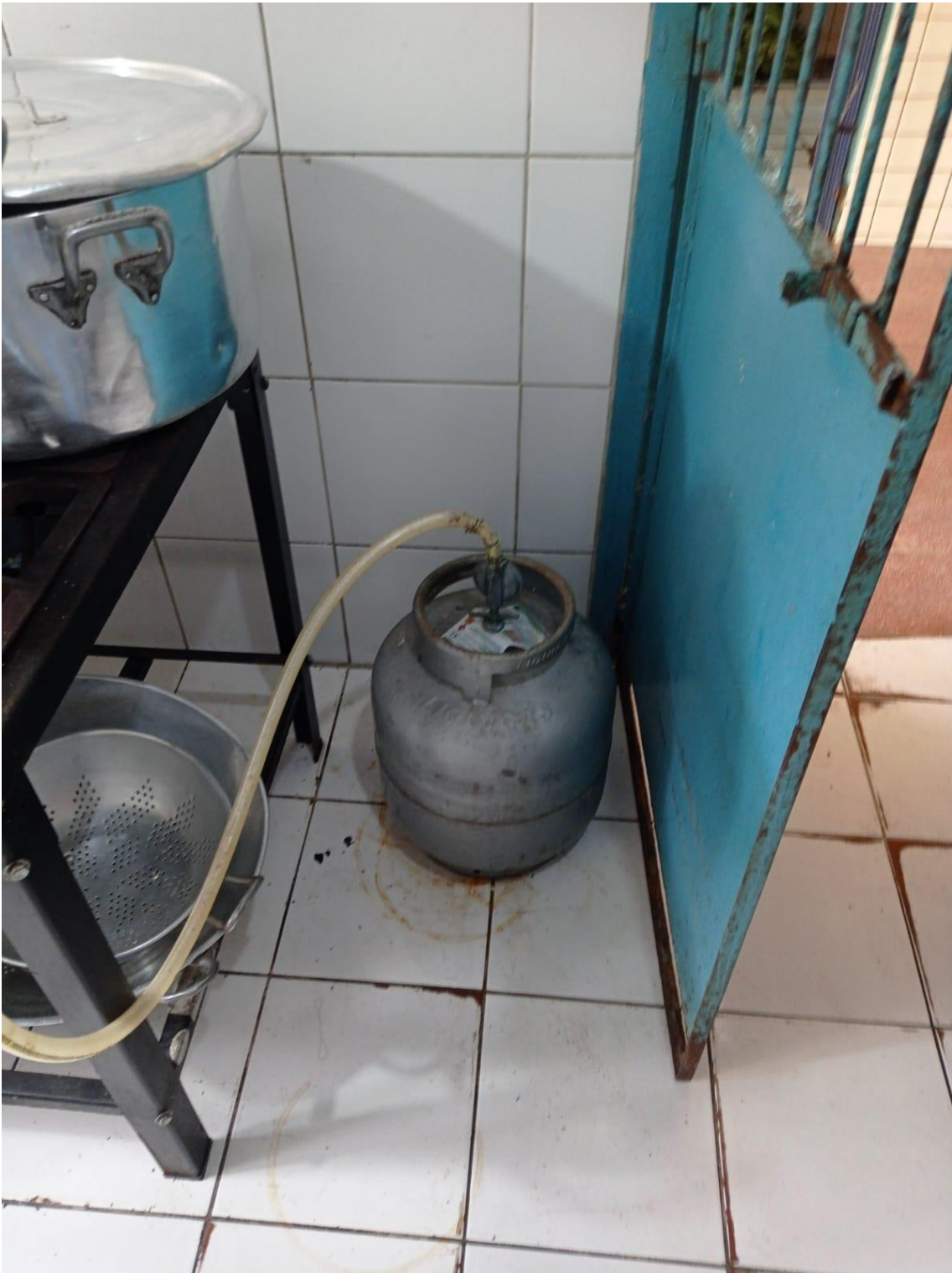
Botijões de gás dentro do depósito de alimentos.
